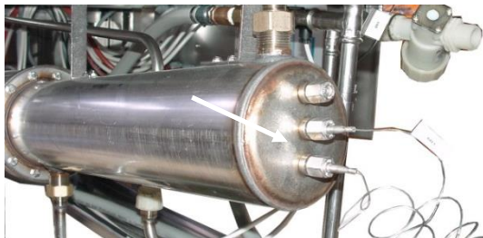
Sicherheitstemperaturbegrenzer am Durchlauferhitzer:
