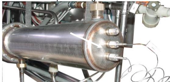
Sicherheitstemperaturbegrenzer am Trocknungs-Heizregister:
