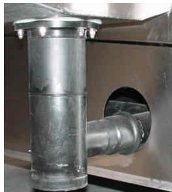
Alle Wasserabläufe der Maschine sind über einen ausreichend großen Geruchsverschluss an das Abwassernetz der Küche anzuschließen.
