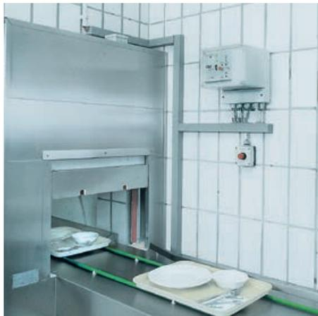
**Feuerschutzabschluss:** Verläuft zwischen der Spülküche und dem Speisesaal ein Brandabschnitt, so muss ein Feuerschutzabschluss vorgesehen werden.
