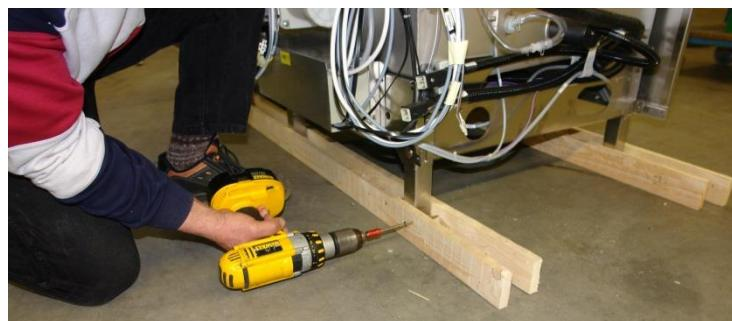
Затем следует удалить все шурупы/винты и деревянные детали.
