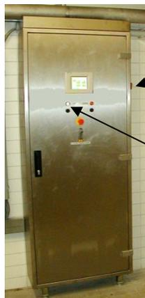
Hauptschalter seitlich am Elektroschaltkasten einschalten!
