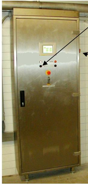
Die Drucktaste „Steuerung AUS“ am Elektroschaltkasten im Müllraum drücken!
