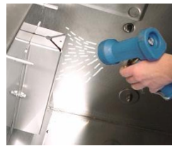
Limpie con chorro de agua el flotador del tanque.
