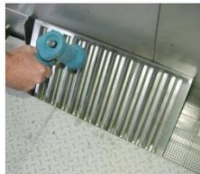
Reinigen Sie den Kondensatsabscheider.
