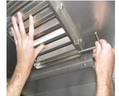
Entfernen Sie den Kondensatsabscheider.
