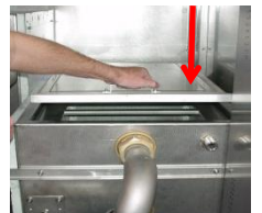
Setzen Sie die Trittbleche wieder ein.
