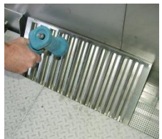
Reinigen Sie den Kondensatsabscheider.
