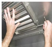
Entfernen Sie die Trittbleche aus der Washkammer.
