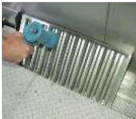
Reinigen Sie den Kondensatabscheider.
