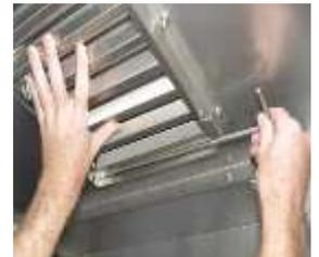
Entfernen Sie den Kondensatabscheider.
