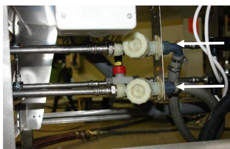
Штуцер водопроводного подключения машины находится, как правило, под выходом.
