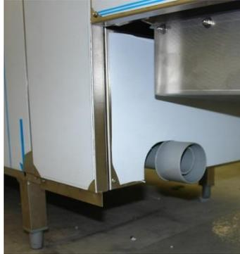
Alle Wasserabläufe der Maschine sind über einen ausreichend großen Geruchsverschluss an das Abwassernetz der Küche anzuschließen.
