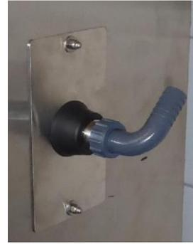
9. Monter la plaque de recouvrement avec la rondelle et l'écrou borgne (M5). Poser le raccord de tuyau à 90°.
