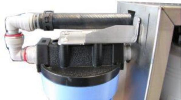
4. Raccorder le réseau d'alimentation d'eau au pré-filtre à l'aide d'un collier de serrage à ressort et relier la fiche de raccordement coudée.
