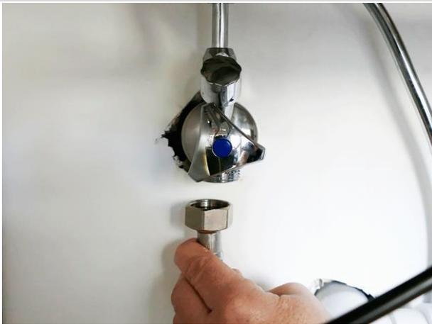
1. Den Zulaufwasserschlauch mit den bauseitigen Anschlüssen verbinden.
