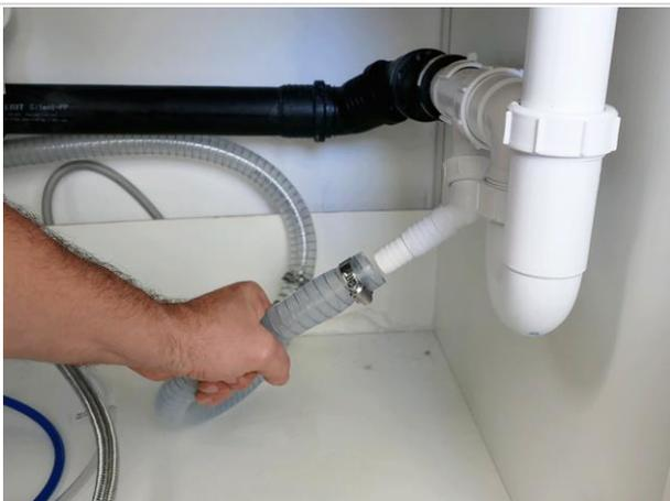
1. Den Abwasserschlauch mit einer geeigneten Ablaufgarnitur am bauseitigen Anschluss anschließen.
