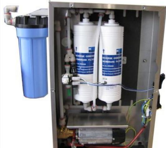
Beim separaten GiO-MODUL die Schläuche für Permeat, Permeatrückführung, Konzentratabgang und der Zulaufschlauch zum Vorfilter anschließen.
