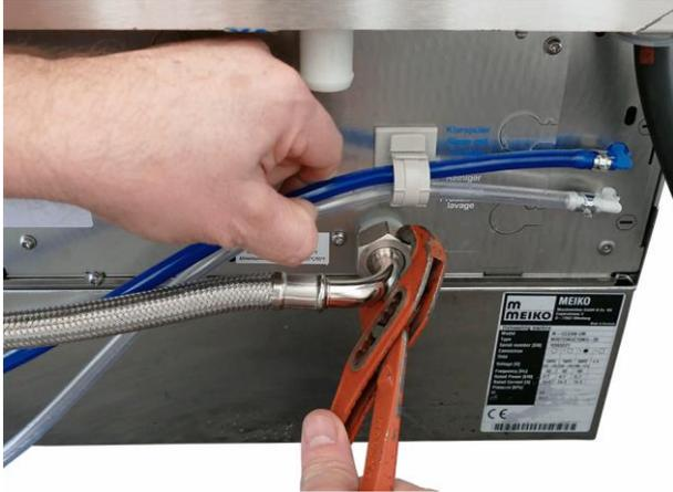
4. Das gebogene Ende des Zulaufwasserschlauchs an der Maschine anschließen und mit einer Rohrzange festziehen.
