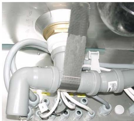
Alle Wasserabläufe der Maschine sind über einen ausreichend großen Geruchsverschluss an das Abwassernetz der Küche anzuschließen.
