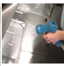
Limpiar con chorro de agua el flotador del tanque.
