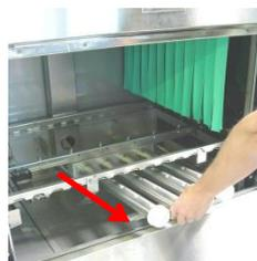
Снимите моечную систему.
